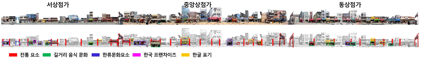
Figure 4. 코리아타운 상점가 북측 입면 및 경관 요소 (출처 : 본인 촬영)
