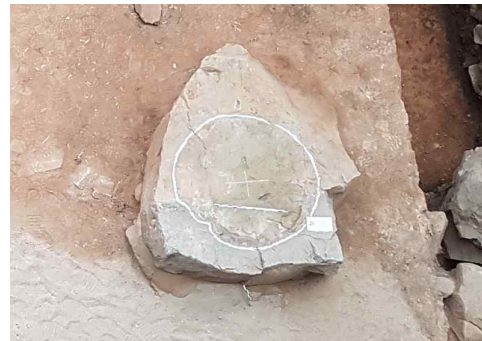
그림2. 여수 진남관 초석 파손
