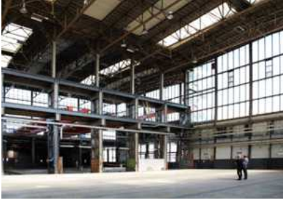
그림 5. 기존의 H-Beam 구조체
