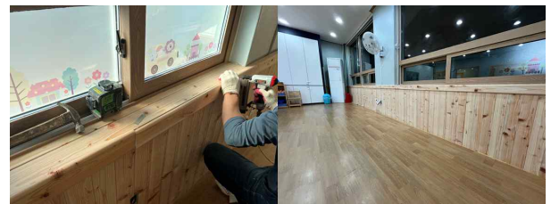
그림 2 목질화 리모델링 시공 및 현황
