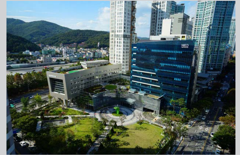
▶ 분당 국립국제교육원 National Institute for International Education 위치 성남, 대한민국 연면적 24,998㎡ 구조 R.C 규모 지하 2층, 지상 10층 수행범위 CM Location Seongnam, Korea Total Floor Area 24,998㎡ Structure R.C Floors 10 Stories and 2 Basements Business Field CM
