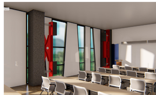
LTMD 적용 예시 [인근 기둥에 설치, 마감 전]
