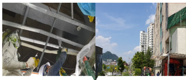
체육관 시설 GFRPU 공법 적용 현장사진
