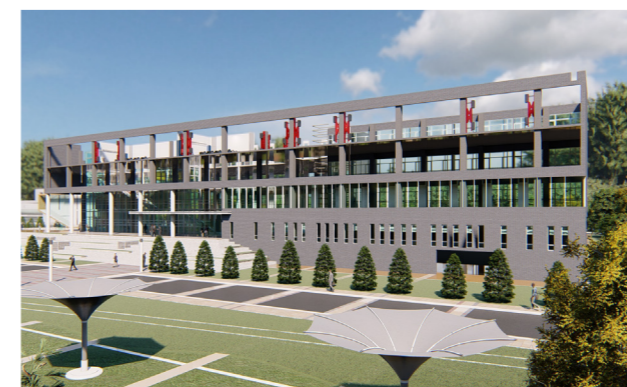
LTMD 설치 후 건물 외관 마감 전
