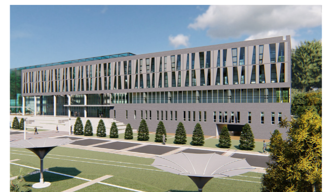
LTMD 설치 후 건물 외관 마감 후
